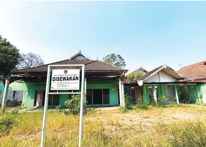
Eks Rumdin Kadinkes di Jalan Ahmad Yani Kota Madiun yang bakal mendapatkan rehabilitasi.
